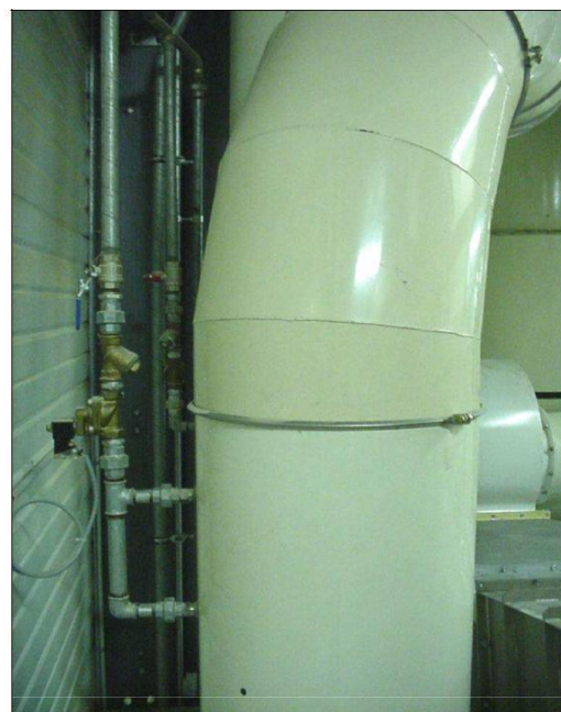
Système d'extinction associé par pulvérisation d'eau
