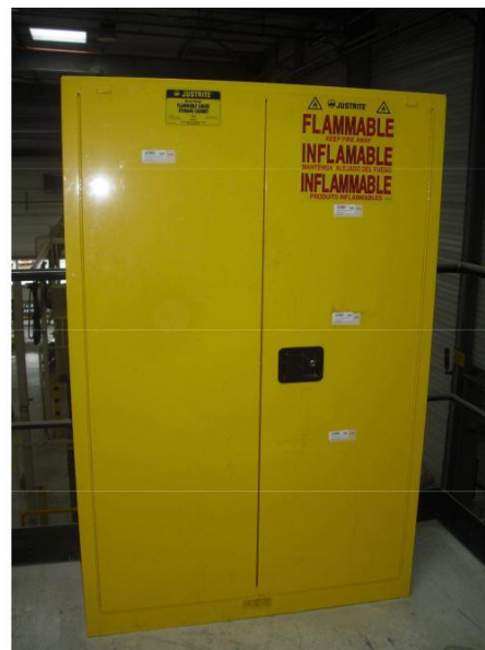
encres dans des armoires de sécurité
